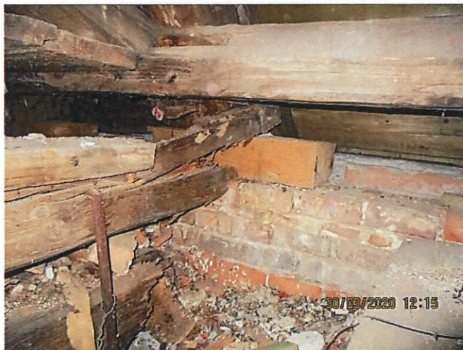
Massive Schädigung Zerrbalkenaufleger
