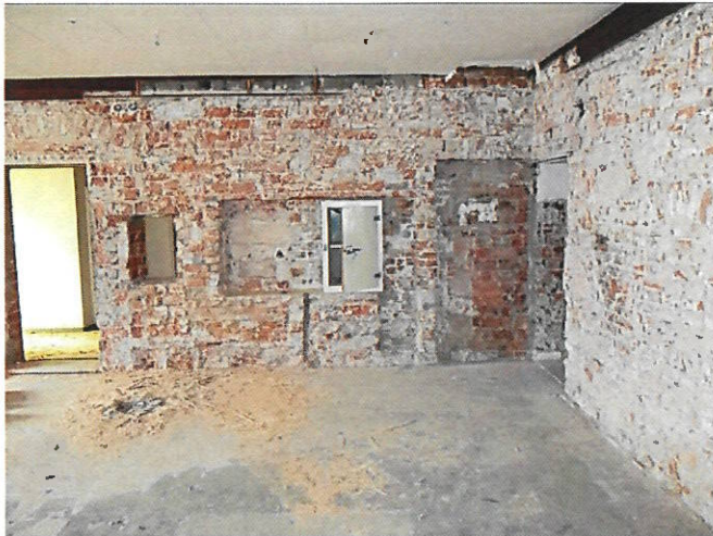
Putzrücknahme Gastraum Erdgeschoss
