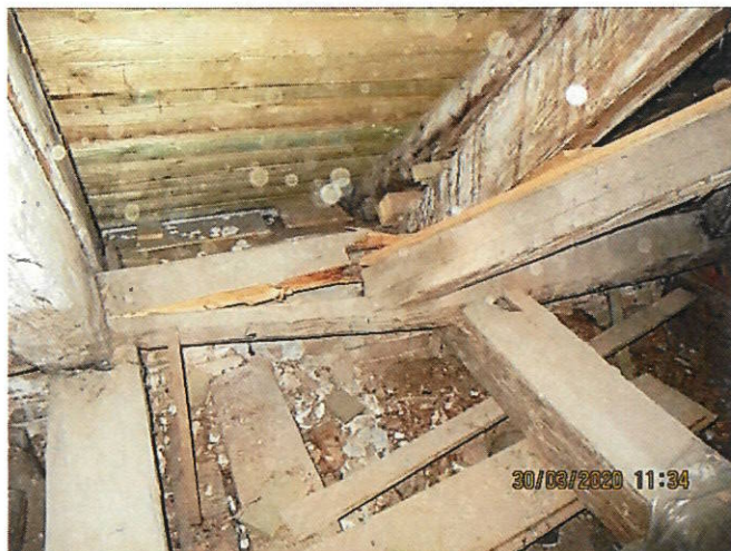
Massive Schädigung Zerrbalkenaufleger
